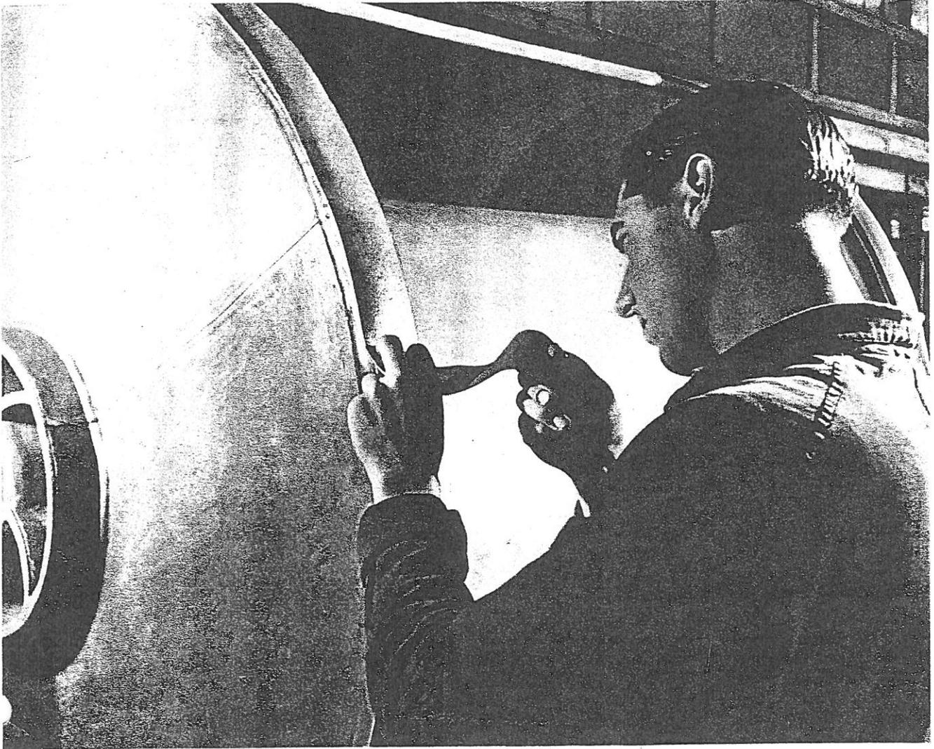
Belegen der Ränder eines Filteraggregats
