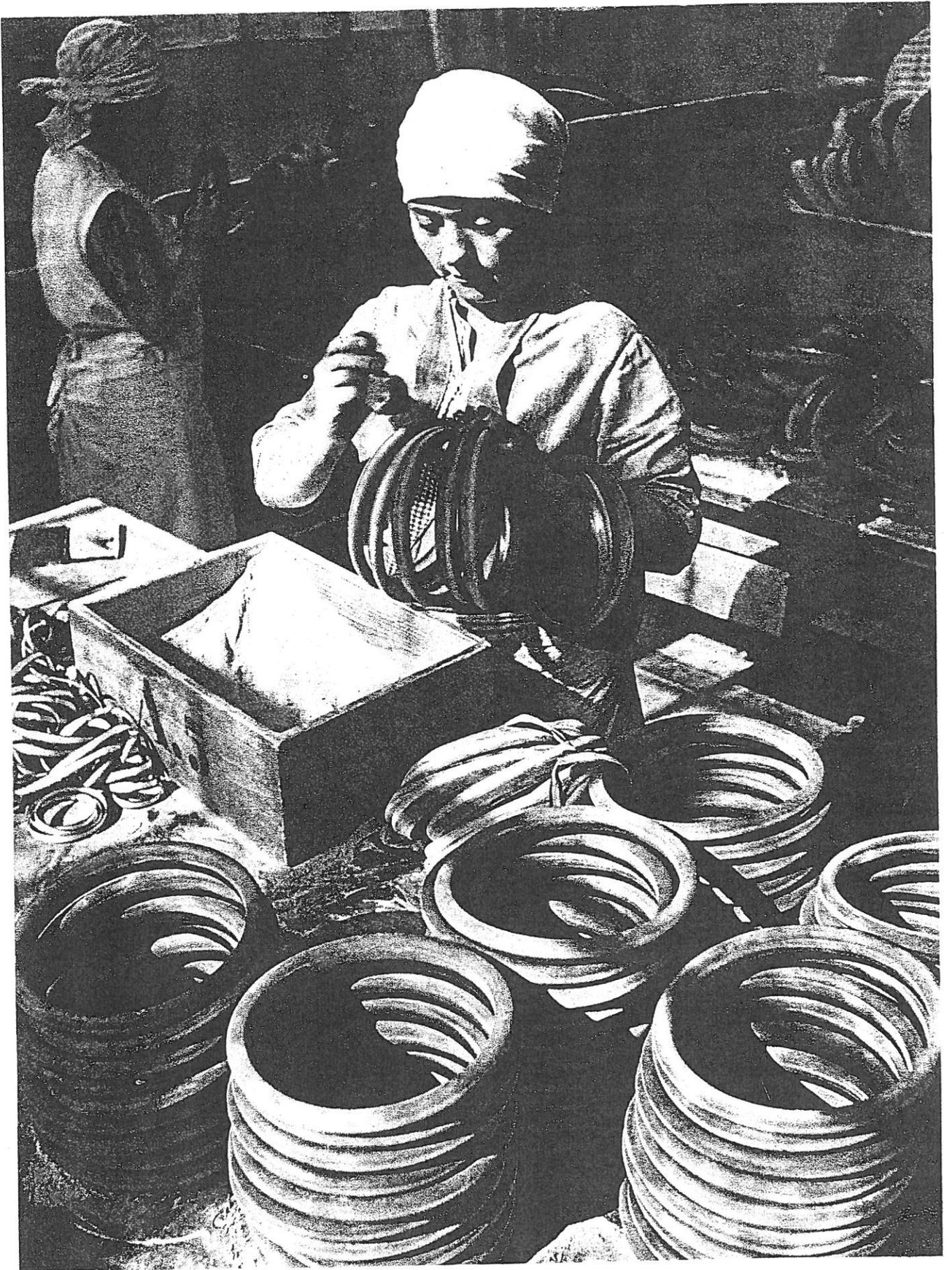
Nachsehen und Stempeln des Fertigfabrikats
